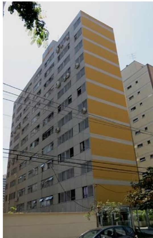
Figura 4: Imagens do Edifício Modular Alfa – 1970. (fonte Lima, 2013, p. 38)
