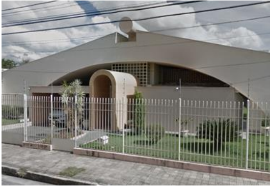
Figura 8. Residência Hélio e Joana (fonte: GoogleEarth, 2019).
